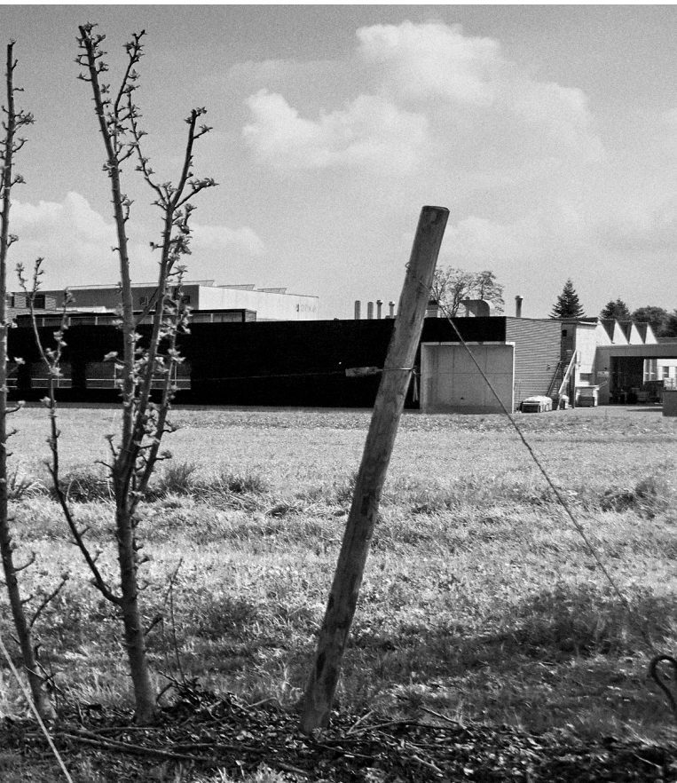
Alle Prozessschritte finden sich bei peka unter einem Dach. Fabrikationsgebäude in Mosen.
